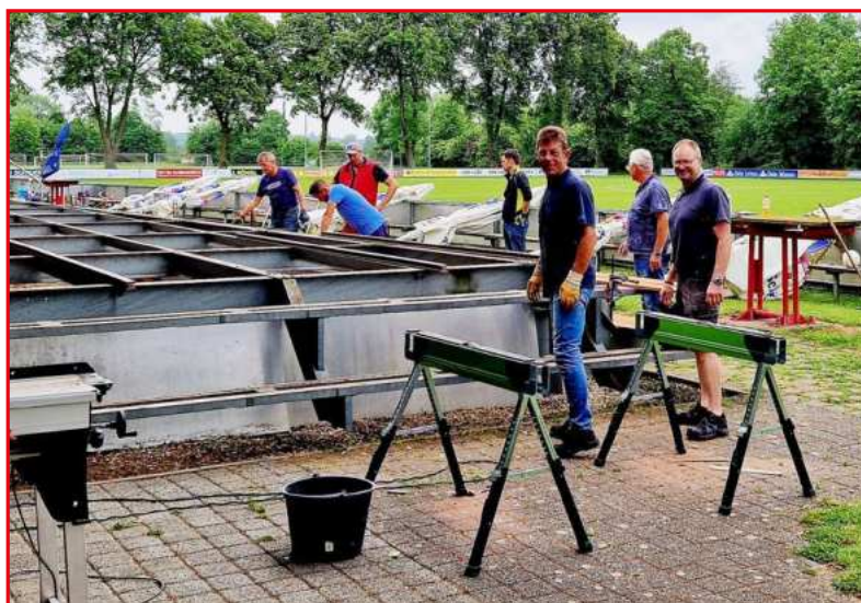
Die Sanierung der Sportheim-Tribüne wurde größtenteils in Eigenleistung bewerkstelligt.
